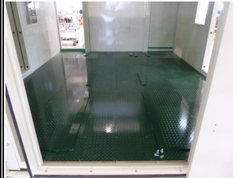
室内デッキプレート
