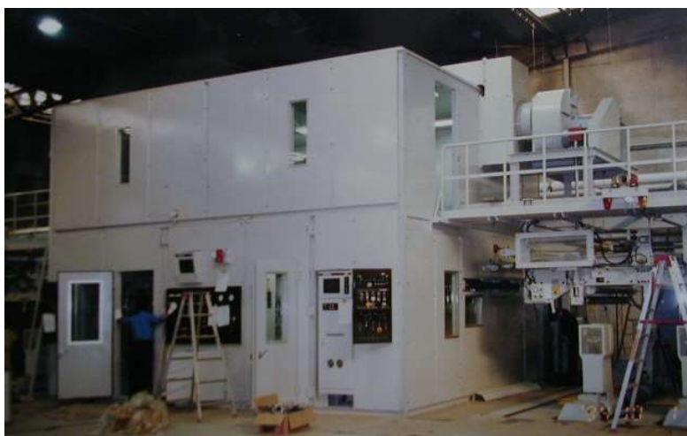
コルゲータ防音室
